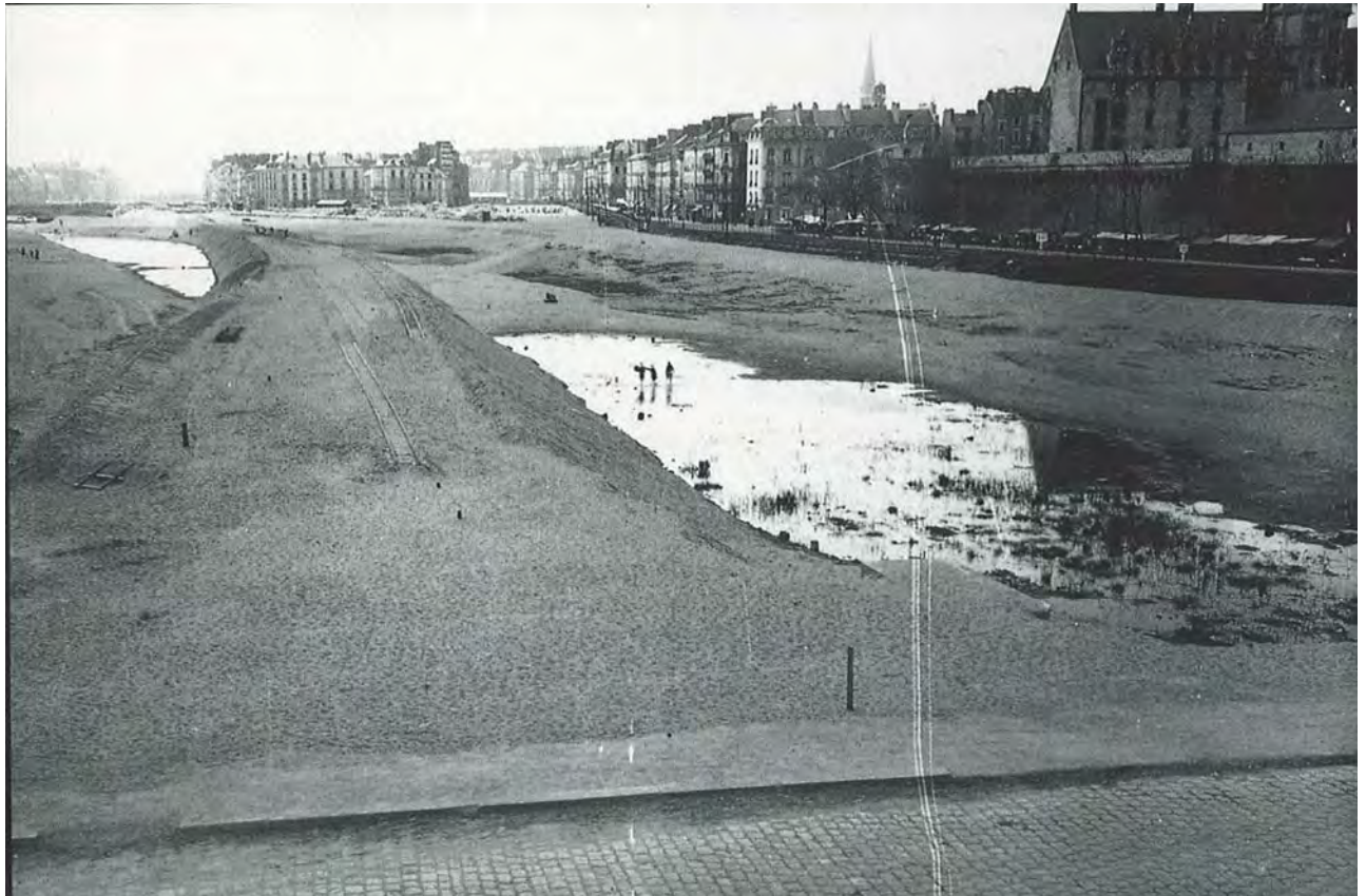
fig 1. Bras de l'Hôpital, avril 1941. Au centre, le terrassement devant accueillir la voie ferrée, à droite, l'emplacement réservé au « Miroir d'eau ». (in « Nantes, le comblement de la Venise de l'Ouest, Chantal Cornet, éditions CMD, 1996)
