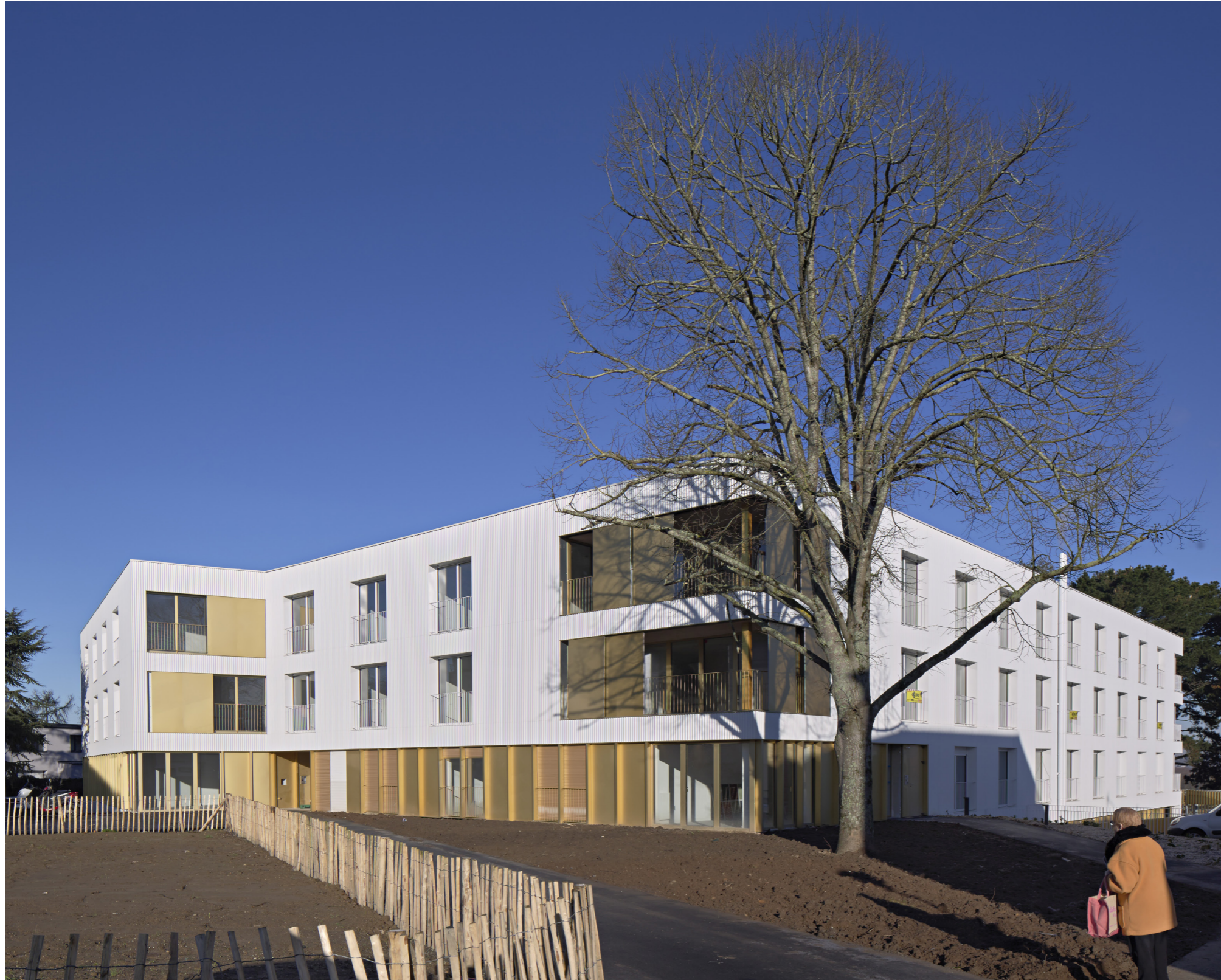
Photo de la façade sud ↓
